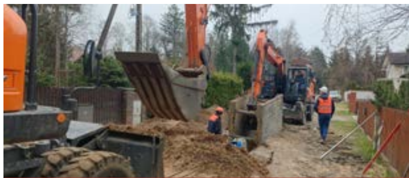
Budowa kanalizacji w Niewodnicy Kościelnej.
